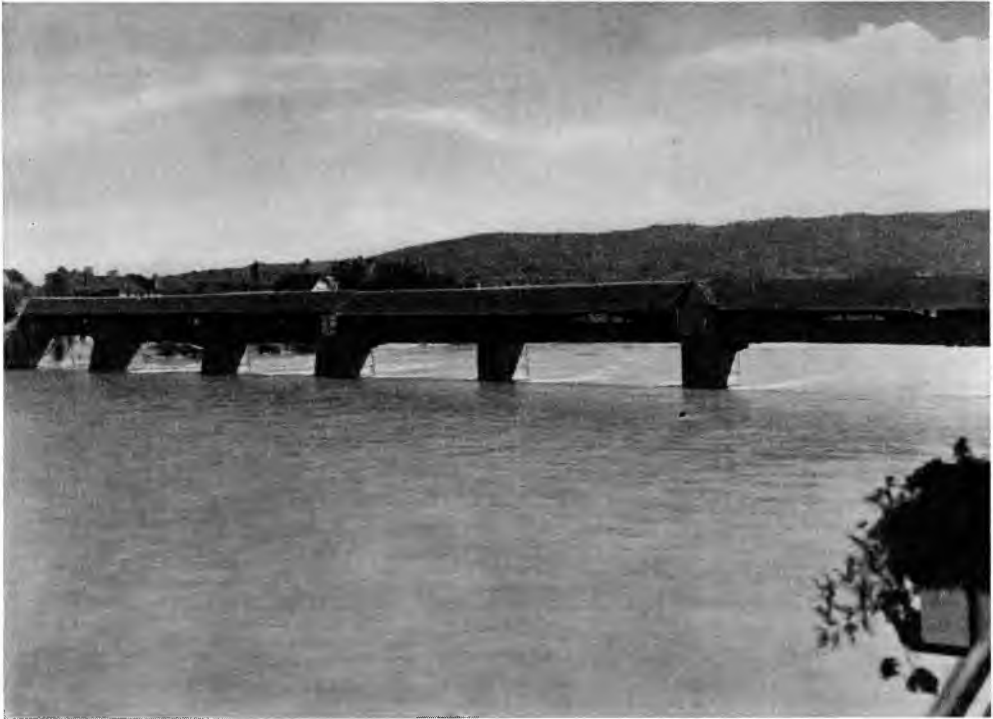
Die alte Rheinbrücke bei Säckingen
