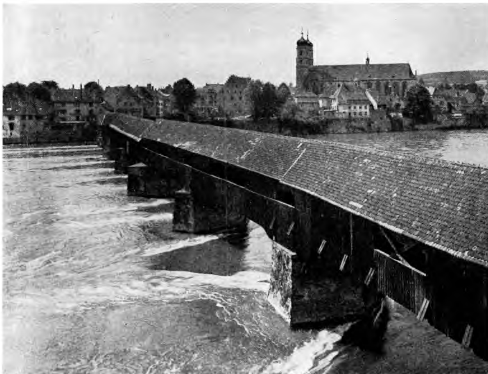
Säckingen mit der Rheinbrücke
