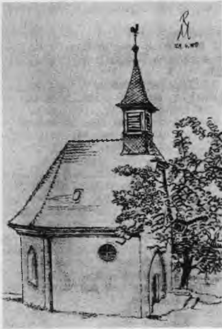
Abb. 14 Ev. Kirche in Neckarkatzenbach
