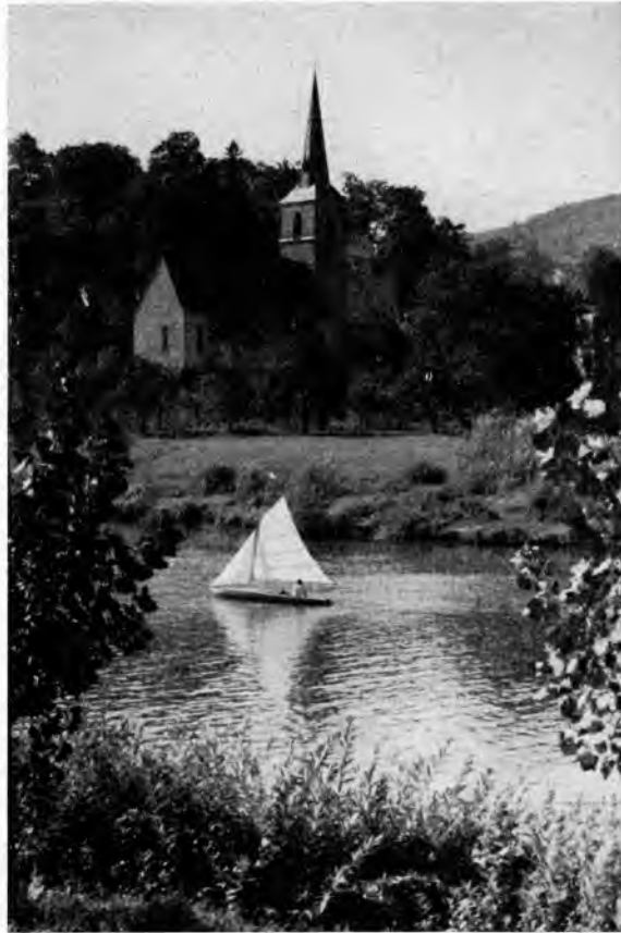
Notburga-Kirchlein in Hochhausen a. N. phot. O. Müller
