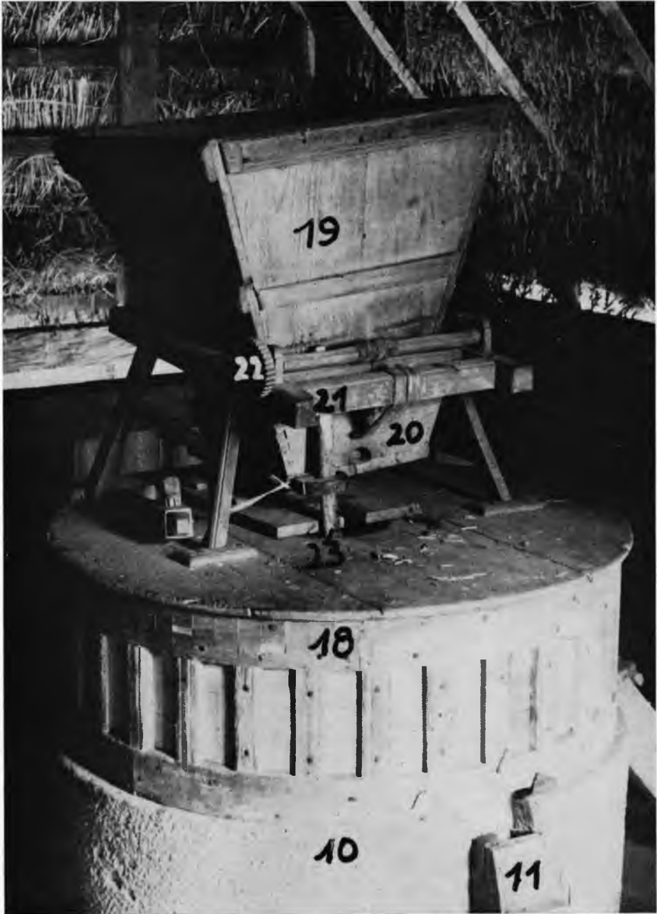
Abb. XIII Einlauftrichter. 10 Bodenstein u. Mehrohr, 18 Zarge, 19 Tromella, 20 Rührtrögle, 21 Rüttelstuhl, 22 Rädle mit Holzwellen zum Heben und Senken des Rührtrögles.
