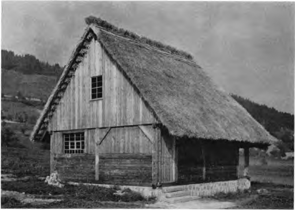
Abb. I Mühle des Vogtsbauernhofes in Gutach (Schwarzwaldbahn)
