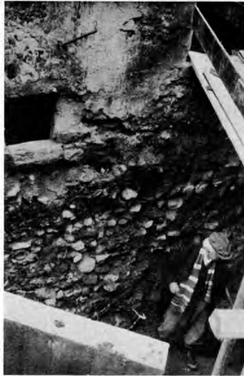
Kanonikatshaus Johanngasse 4 Hofseite, schlechte Ma. Kellermauer. Verf. steht auf dem Ostflügel der röm. Turmmauer
