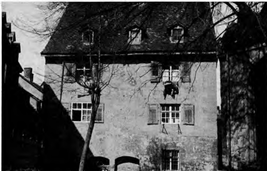
Kanonikatshaus Johanngasse 4, Südseite
