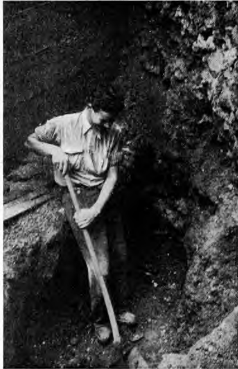
In der Tiefe r. vom Arbeiter südl. Umfassungsmauer der röm. Villa. Darüber Ma. Kellermauer
