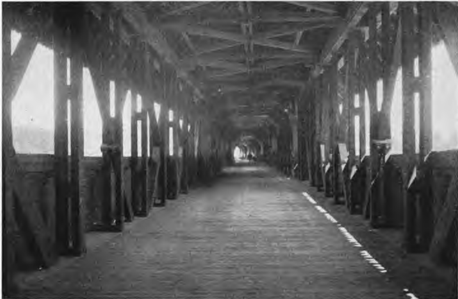
Abb. 10 Neuerer Teil der Rheinbrücke mit den Windversteifungen zwischen den Gurten
