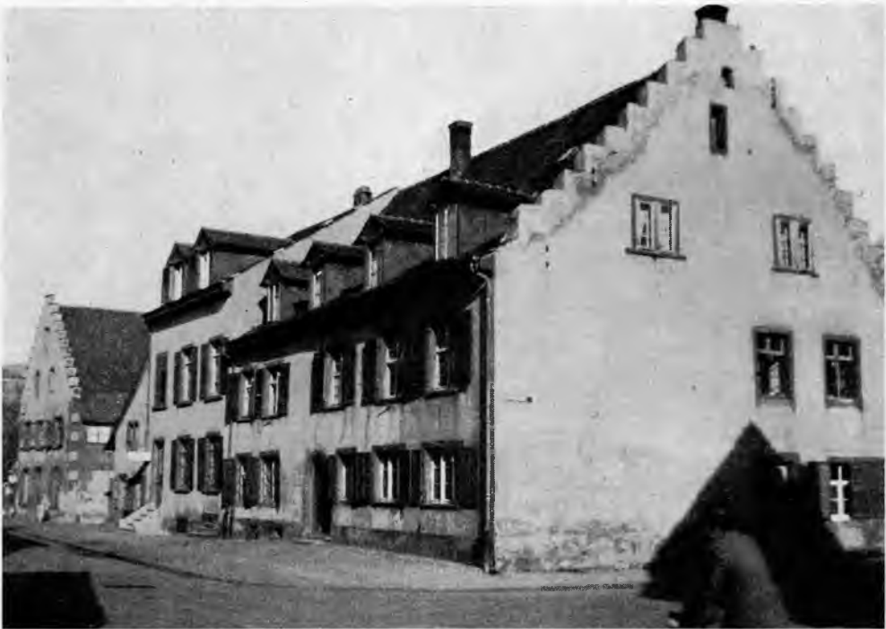
Bild 8 Altes Kapitelhaus und altes Spital
