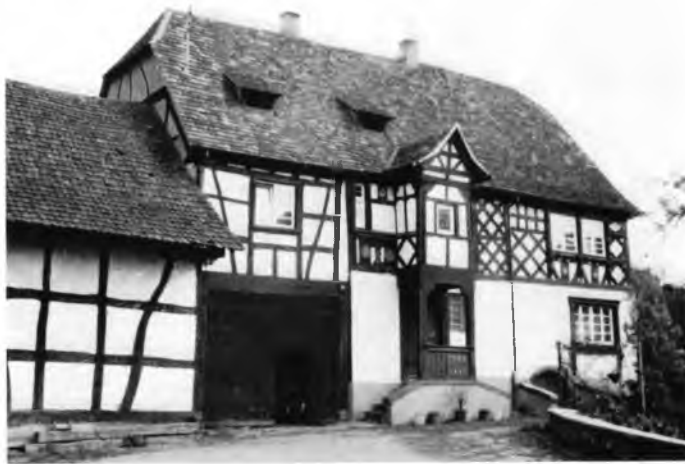
Rust, Der Schloßbau erbaut 1598, wiederhergerichtet 1961 phot. M. Hesselbacher
