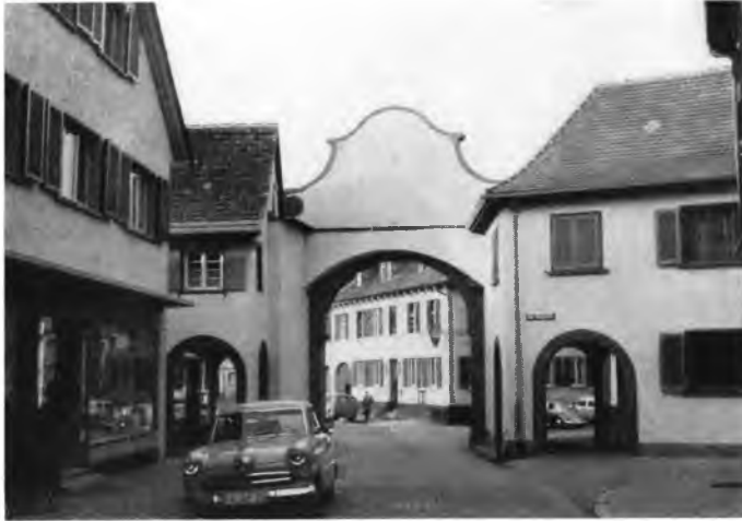
Ettenheim, Das Untere Tor nach der Instandsetzung 1957 (Südansicht) phot. Hesselbacher
