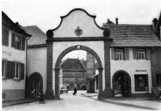
Ettenheim, Das Untere Tor nach der Instandsetzung 1957 (Nordansicht) phot. Hesselbacher
