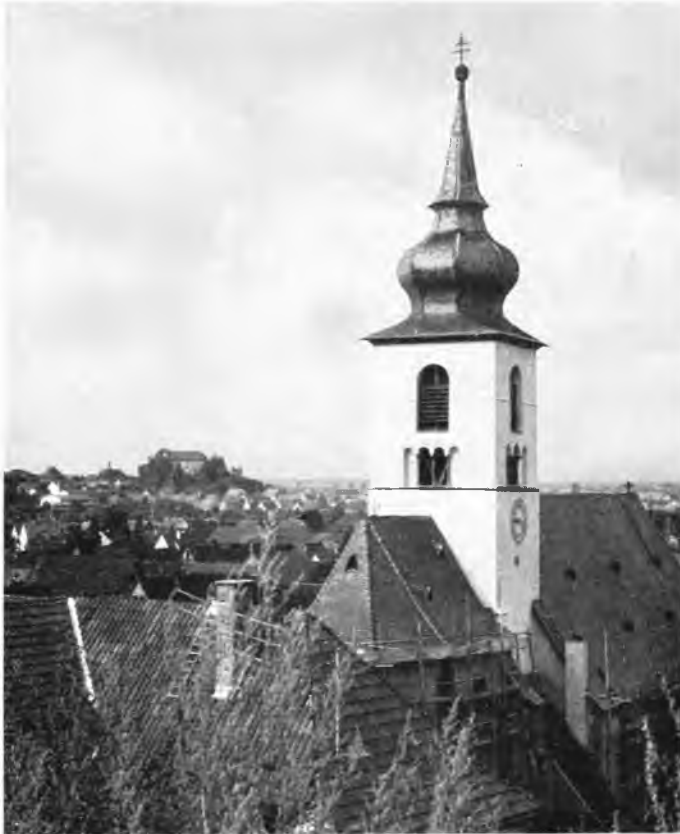
Kippenheim, Turm der Kirche nach der Instandsetzung 1962 phot. K. List
