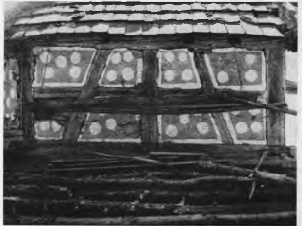
Abb. 1. Burbach b. Ettlingen, bemaltes Fachwerkhaus phot. Hillenbrand
