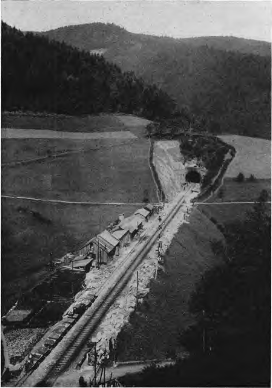
Ausbesserungsarbeiten im Hippenbachtunnel. Der Betrieb muß eingleisig durchgeführt werden.
