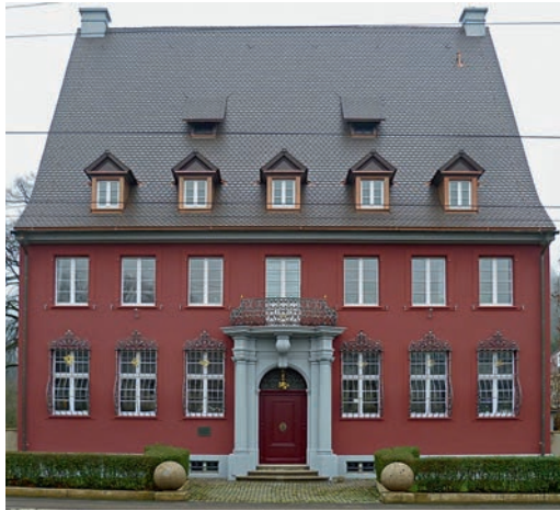
Das frisch renovierte Haus der Badischen Heimat in der Hansjakobstraße (Ansicht Nord)
