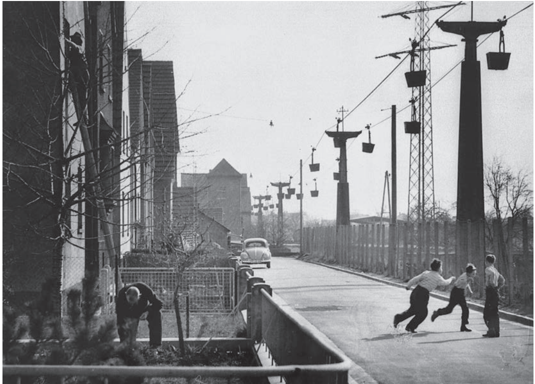
Abb. 9: Die Seilbahn an der Zementwerkstraße in Leimen
