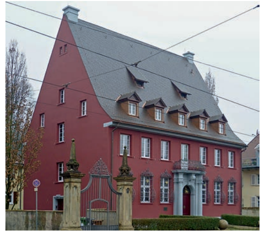
Blick auf die neu gestrichene Fassade (Ansicht Nordost) Beide Abbildungen: Yvonne Falle
