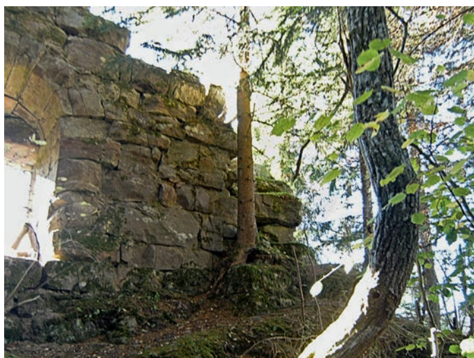
Grundmauern des Bergfrieds
