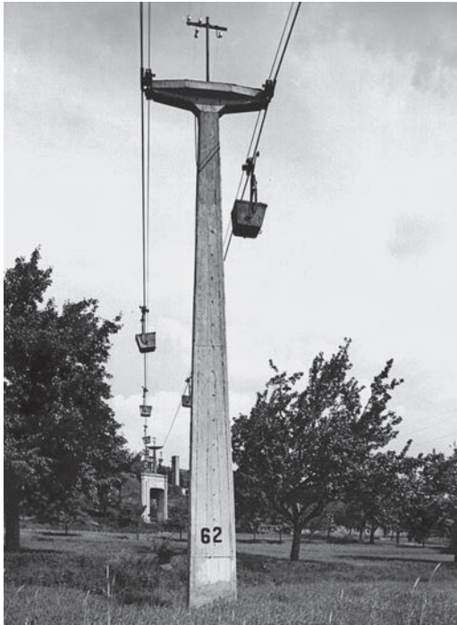
Abb. 10: Seilbahnstützen mit Hängeloren zwischen Nußloch und Leimen (1951)
