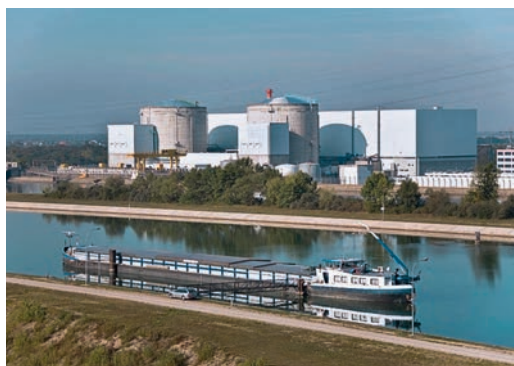
Blick auf das KKW Fessenheim mit den beiden Kühltürmen der inzwischen abgeschalteten Reaktoren (Foto: EDF)
