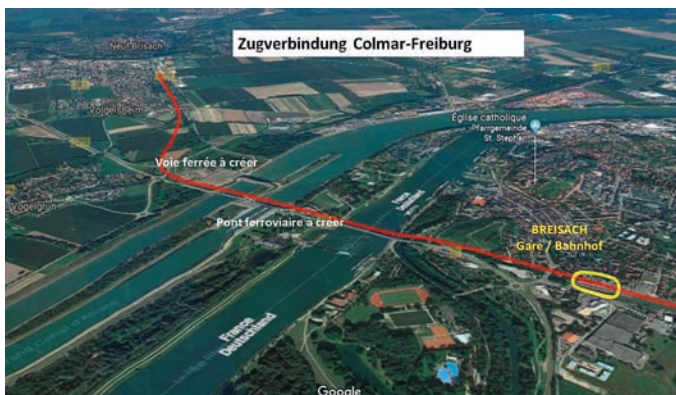
Für die Bahnstrecke von Colmar nach Freiburg soll die im Krieg zerstörte Rheinbrücke zwischen Neuf Brisach und Breisach wieder aufgebaut werden. (Foto: Landratsamt Freiburg-Hochschwarzwald)
